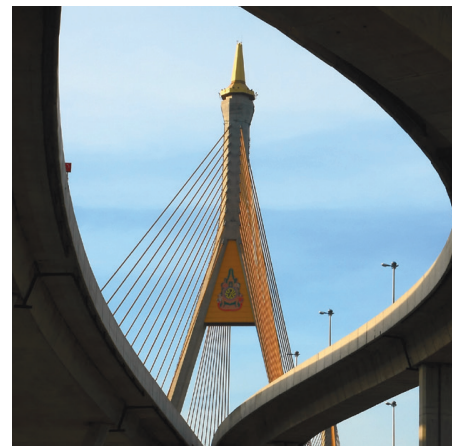
城市土木工程建设
